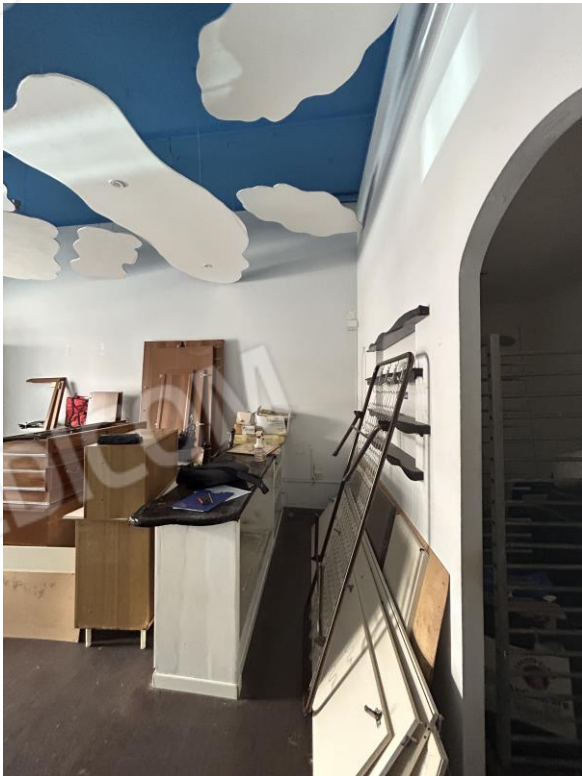
Foto 7 Vista ingresso vano commerciale
