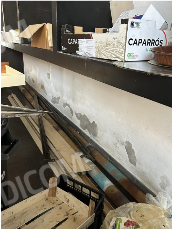
Foto 15 Particolare umidità di risalita muri
