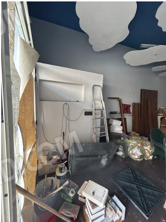
Foto 11 Vista esterna bagno da vano commerciale
