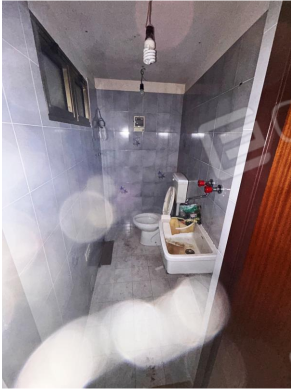
Foto 13 Vista interna bagno
