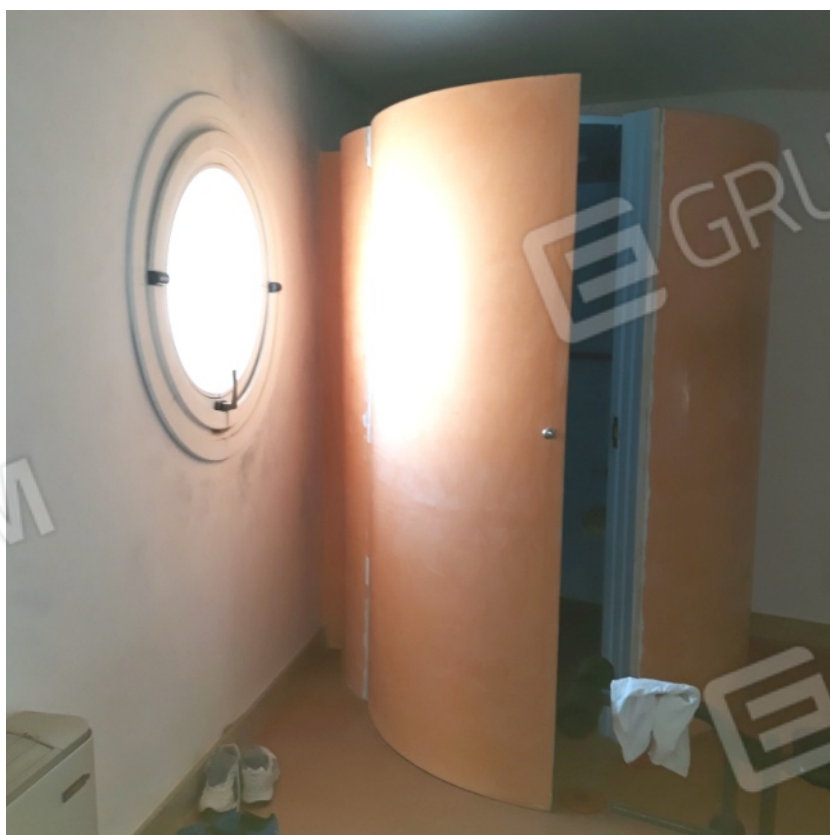
Foto 28 – Piano 2° - Servizio Igienico
