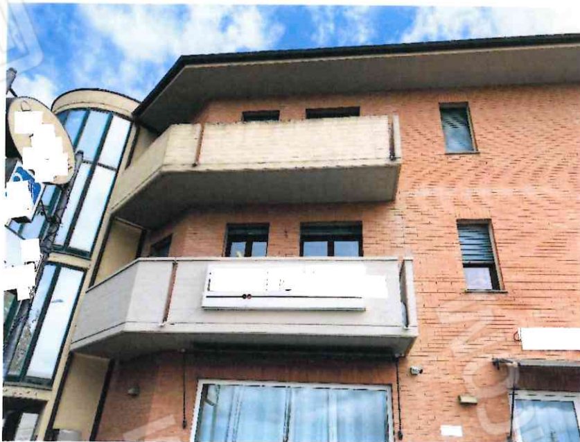
Foto 2 – esterno facciata principale
