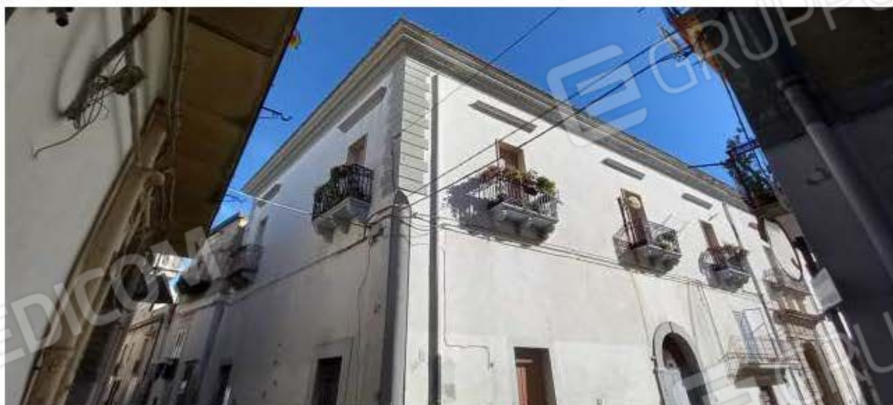
Foto 2 – Prospetto abitazione su Via Pepe e Via Dante
