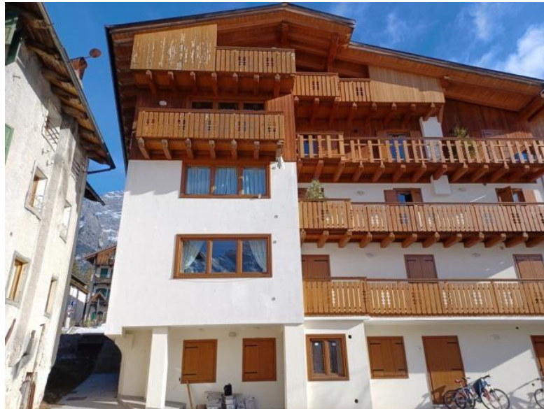
Prospetto sud con entrata unità immobiliare
