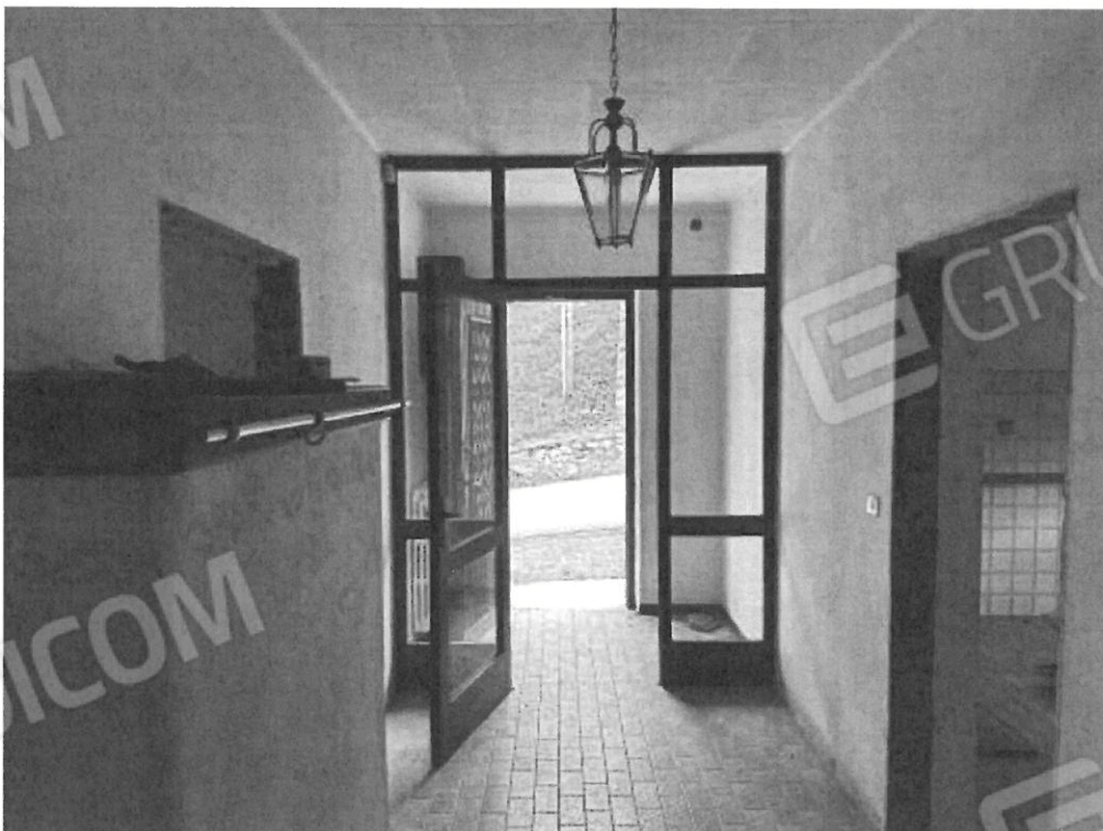
Foto 20: PT (sub. 3) ingresso
