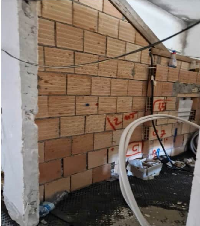
Foto n. 11 –interni unità sub 9-
