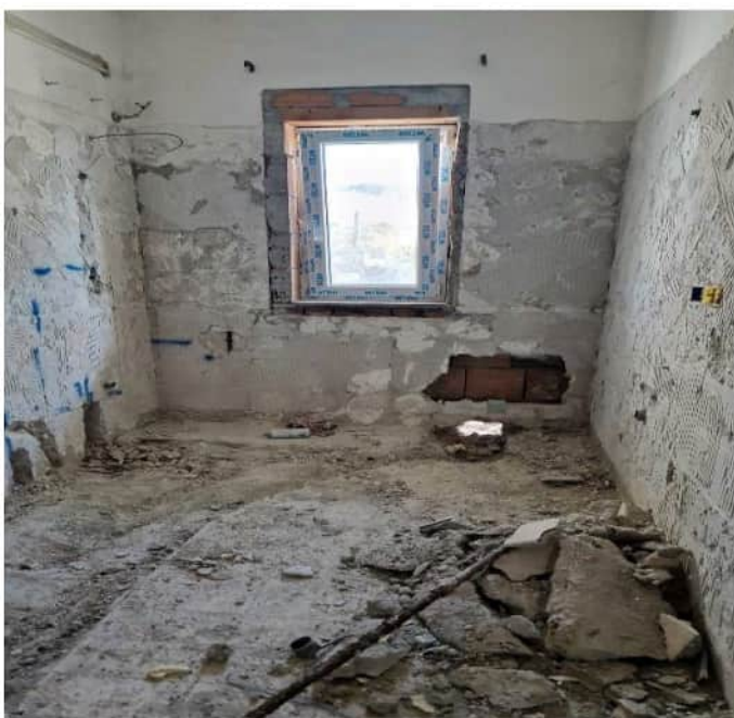
Foto n. 7 –interni unità sub 9-
