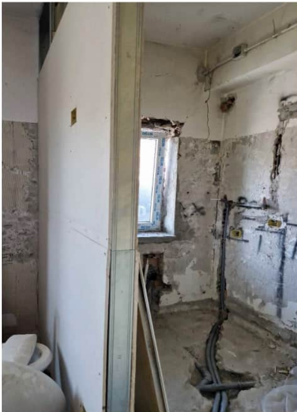
Foto n. 12 –interni porzione unità sub 10-
