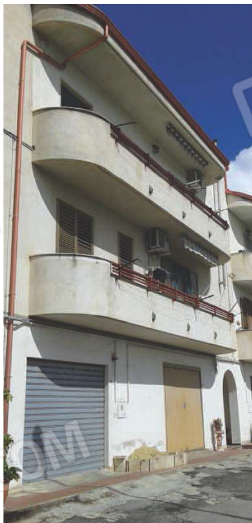
PROSPETTO IMMOBILI – LATO VIA NAPOLI
