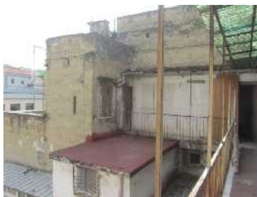
BALLATOIO DI ACCESSO ALL'IMMOBILE
