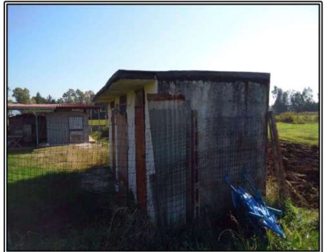
Figura 57 fabbricato in muratura
