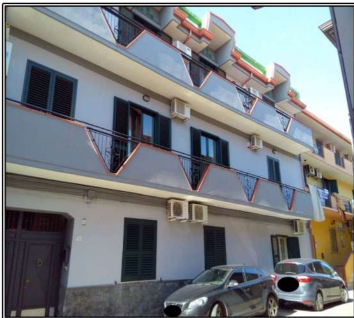
Figura 6 Facciata fabbricato su via Cadorna
