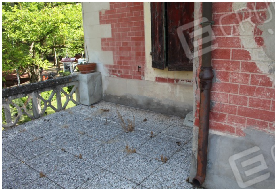
porzione di terrazzo piano primo
