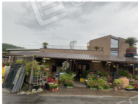
Foto 17: Veduta esterna tettoia in parte abusiva
