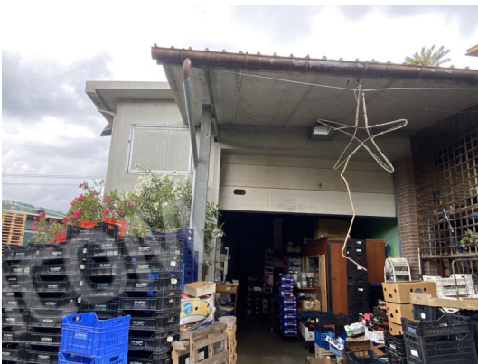
Foto 16: Ingresso Magazzino 2 con tettoia abusiva
