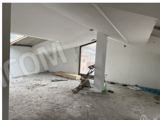
Foto 11: Ripostiglio al grezzo_Sottotetto
