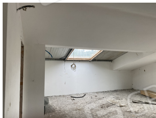
Foto 12: Ripostiglio al grezzo_Sottotetto
