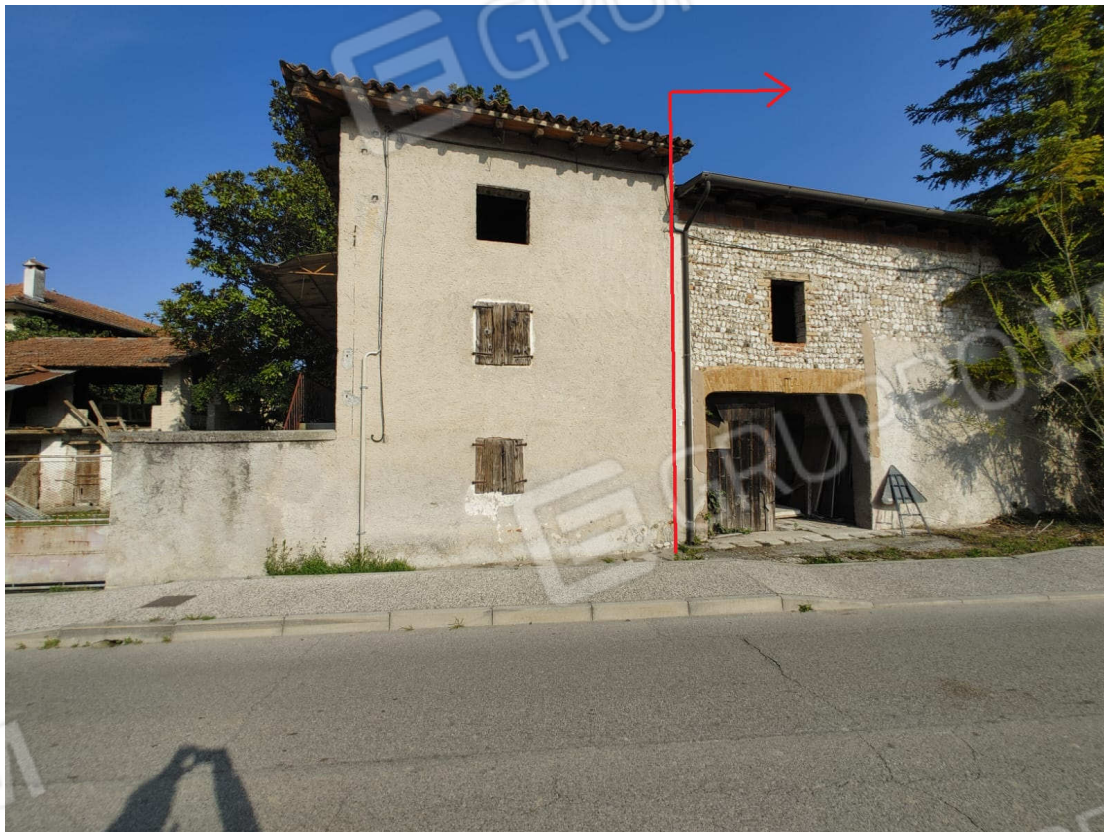
Foto 1 – vista lato SUD - Via Castions
