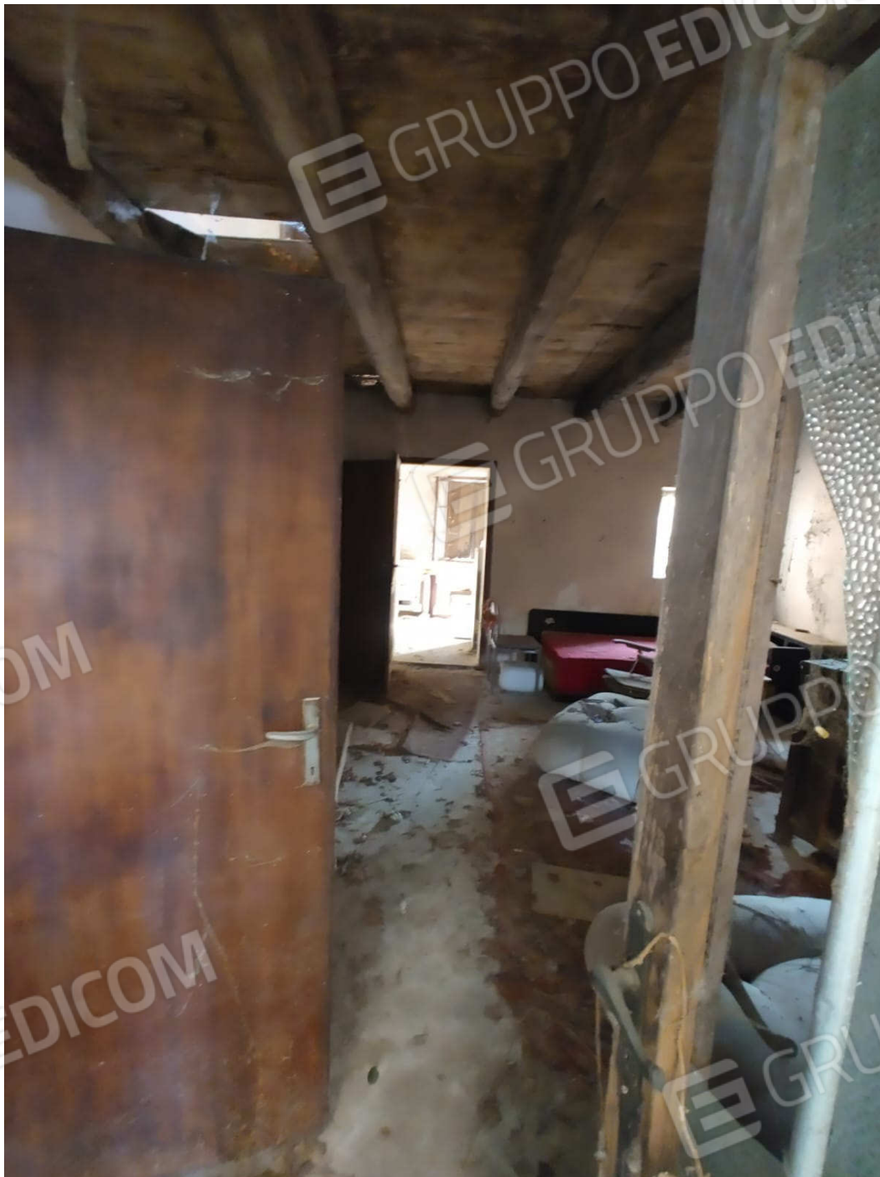
Foto 13 – Viste interne immobili
