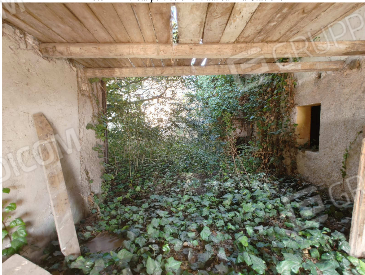
Foto 12 – Vista portico di entrata da Via Castions
