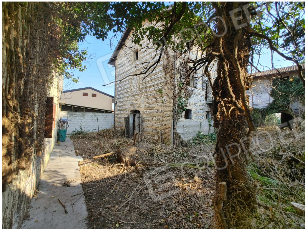
Foto 9 – Vista da Ovest verso Nord del fabbricato interno
