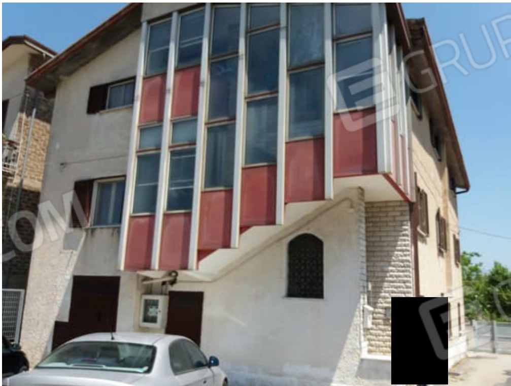
FOTO ESTERNO VANO SCALA MAPPALE 364
