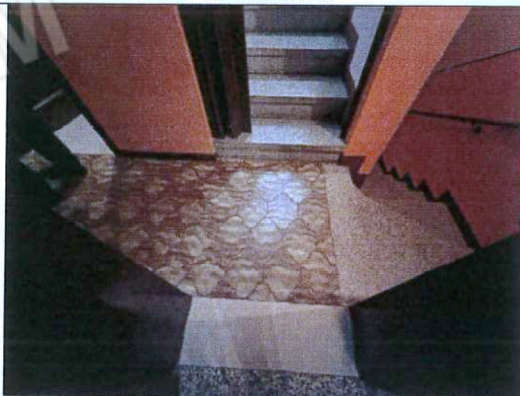
Pavimentazione atrio notte
