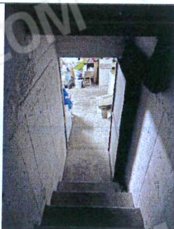
Scala verso cantina piano interrato
