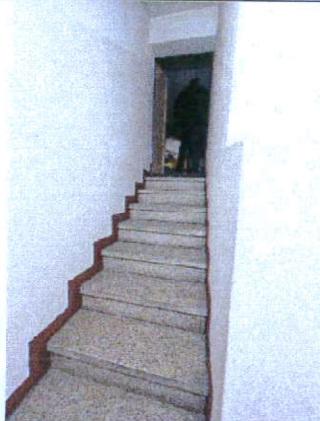
Scala verso sottotetto
