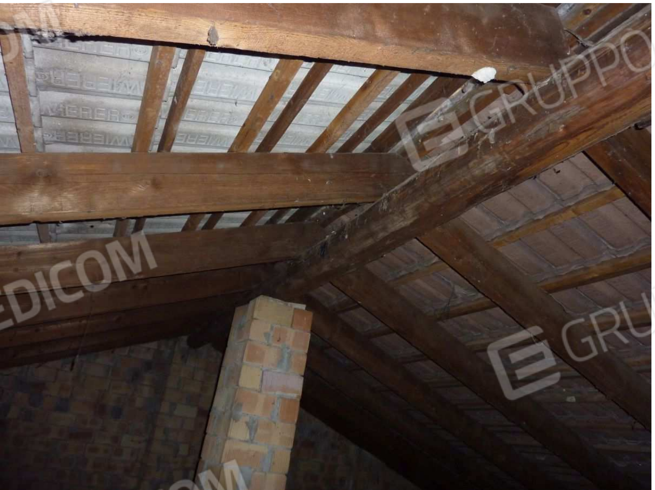
33. Sottotetto soprastante l'abitazione
