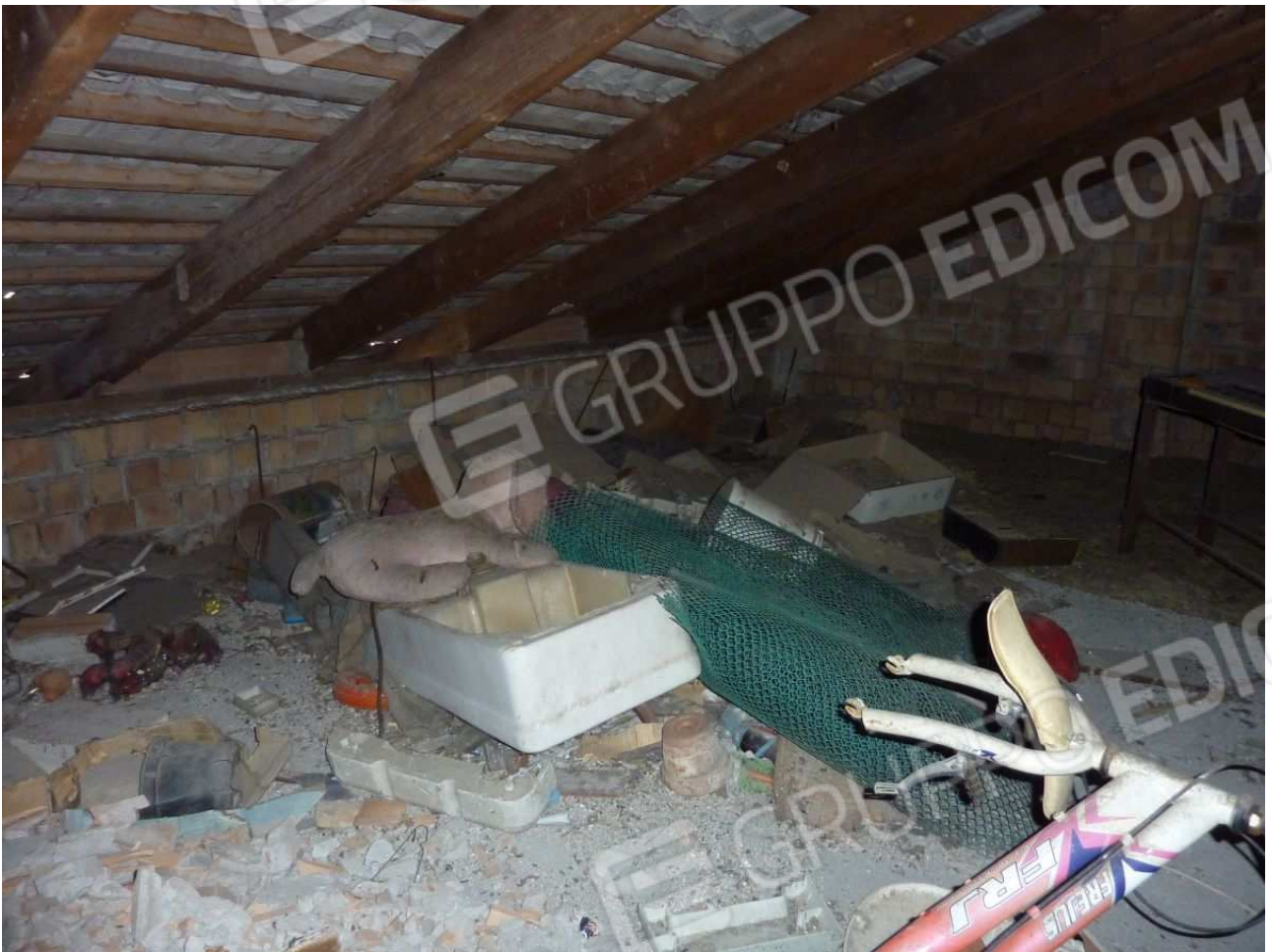
34. Particolari del sottotetto soprastante l'abitazione
