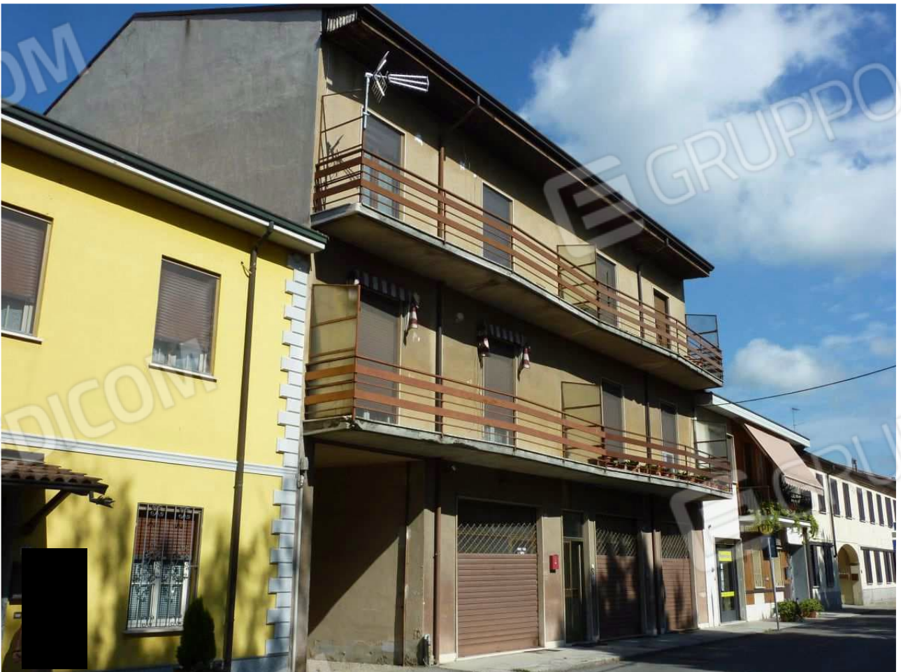
1. Immobili in Via Umberto I n. 22 a Cervesina (PV)
