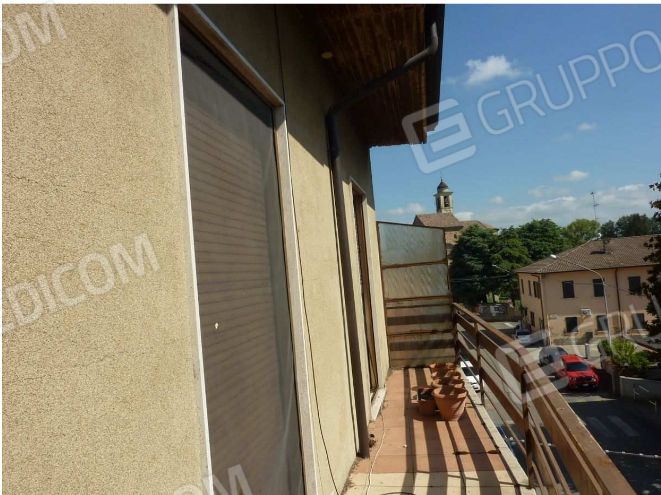
15. Balcone sul fronte strada
