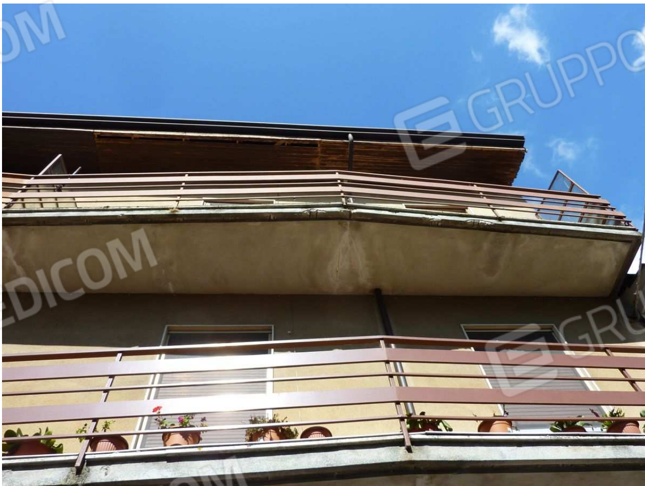
3. Particolari del balcone e della gronda sul fronte dell'abitazione al secondo ed ultimo piano
