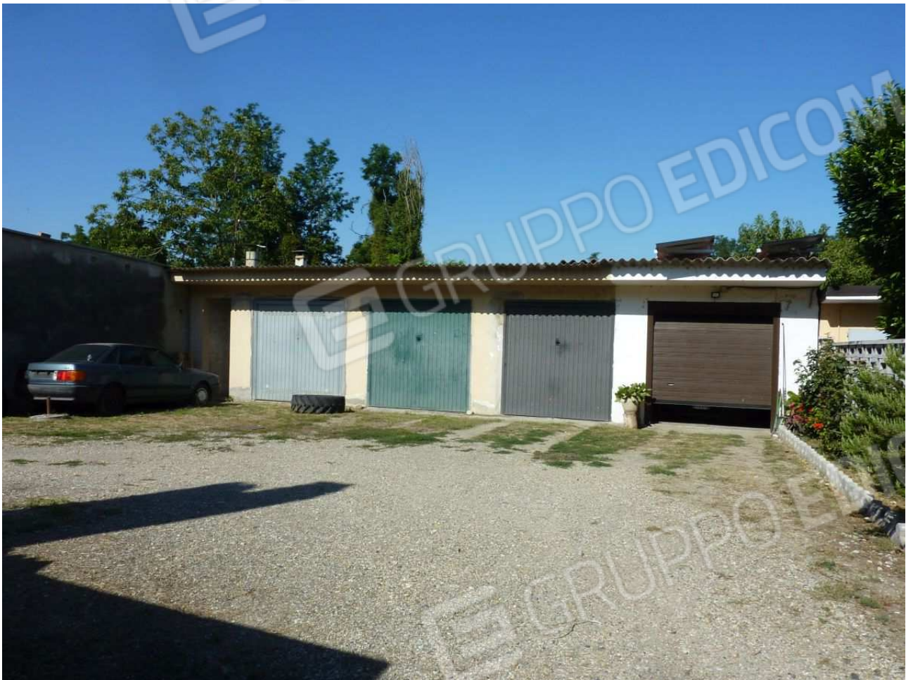
38. Serie di autorimesse nel cortile interno condominiale
