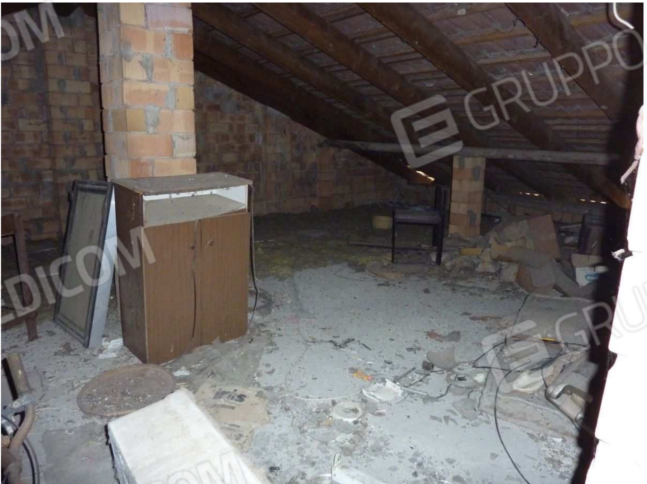
35. Particolari del sottotetto soprastante l'abitazione
