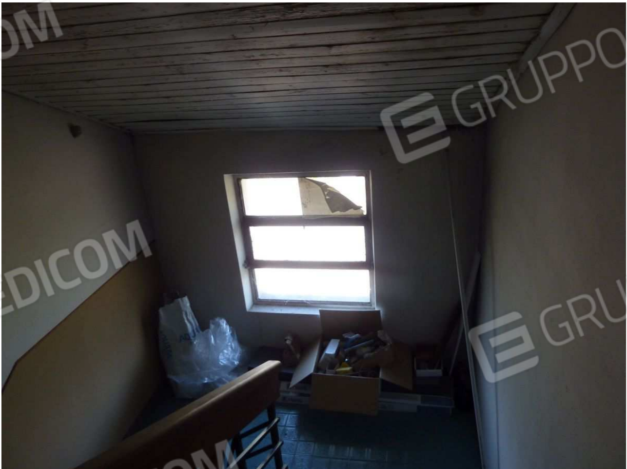
31. Vano scala condominiale d'accesso al sottotetto soprastante l'abitazione
