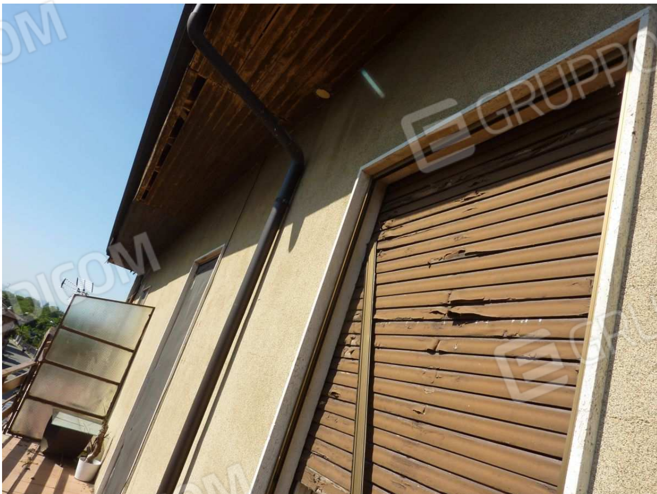
17. Particolari della gronda del tetto sul fronte strada
