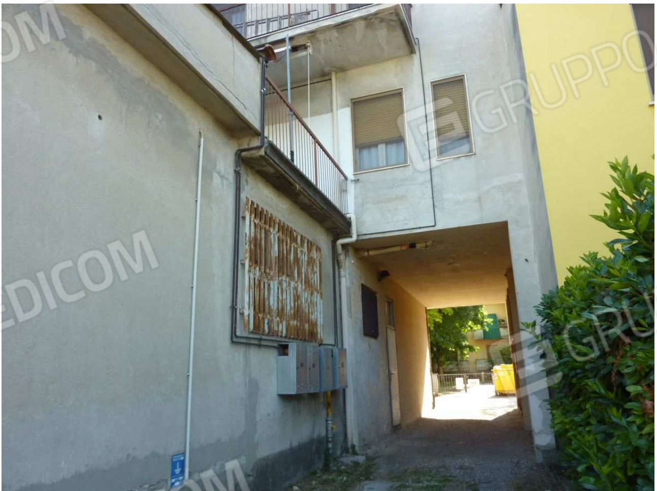
37. Androne d'accesso al cortile interno condominiale
