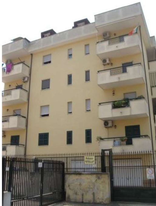
Figura 6 facciata nord ed accesso da via Monti n.4 in Cesa
