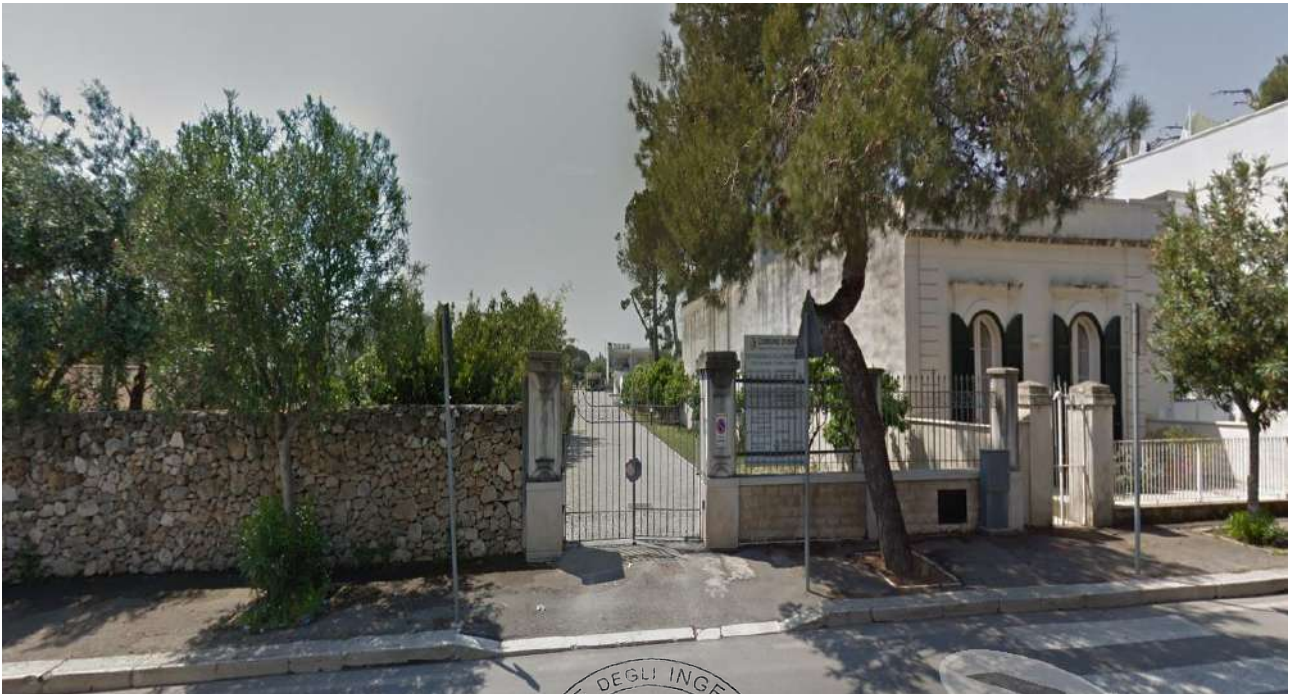
foto n.01 – Ingresso Carrabile – via Bari
