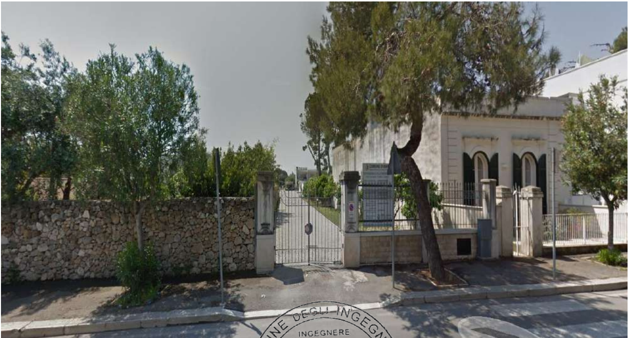
foto n.01 – Ingresso Carrabile – via Bari
