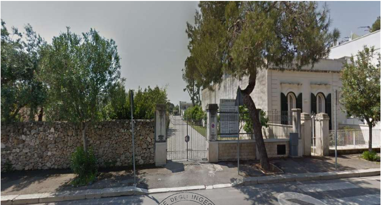
foto n.01 – Ingresso Carrabile – via Bari
