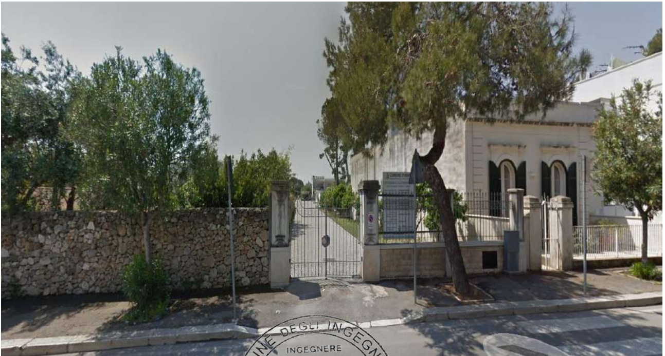
foto n.01 – Ingresso Carrabile – via Bari
