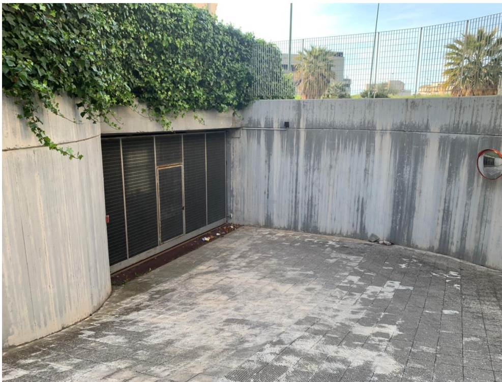
Foto 3 – Rampa di accesso ai locali box auto
