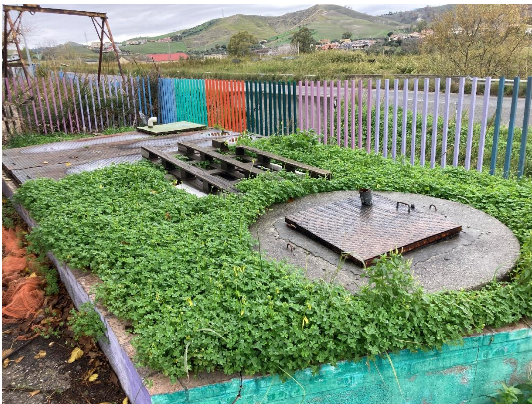
Pozzettone raccolta acque nere
