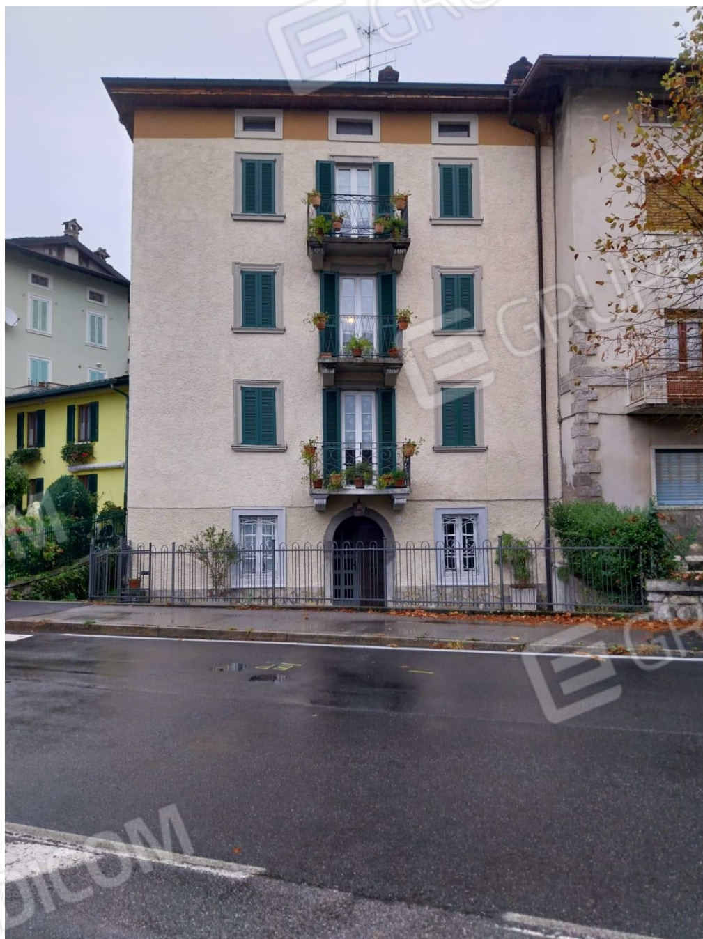
Vista di insieme palazzina
