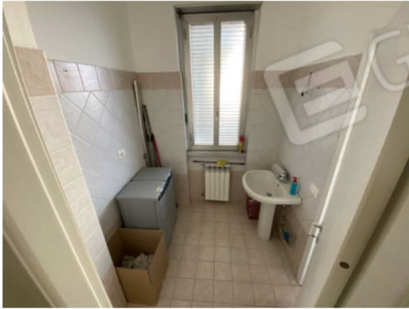
MARTINENGO - VISTA BAGNO
