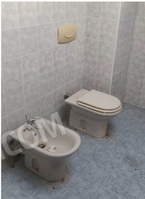
CASTEGGIO- VISTA BAGNO
