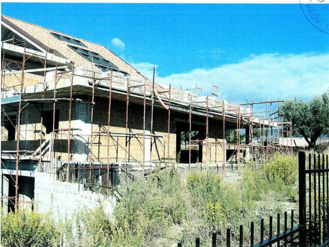
Foto 34 – Cespite n°7: veduta del fabbricato in costruzione in Località Collina Salerni (facciata sud vista di scorcio)
