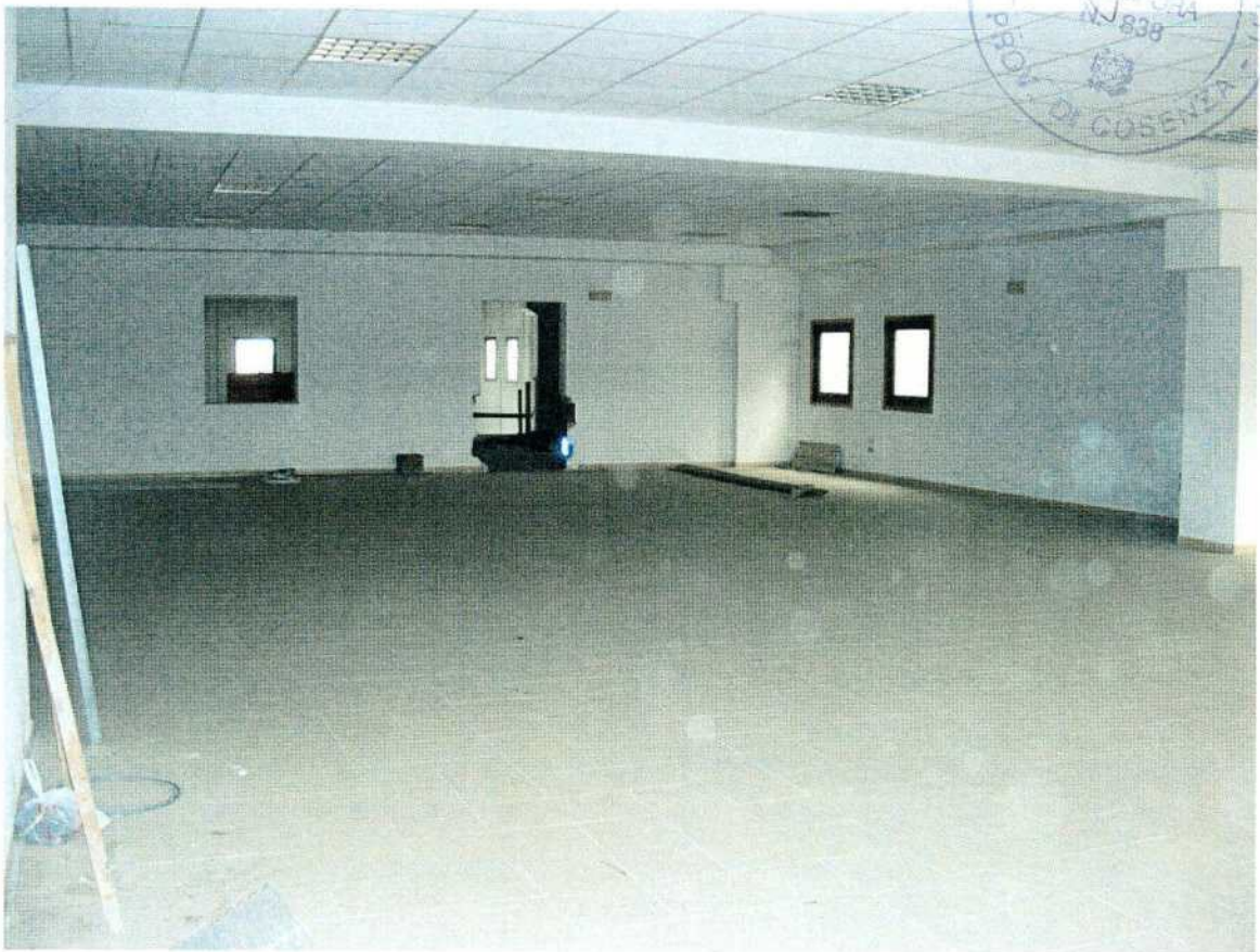
Foto 16 – Cespite n°2: veduta della zona depositi/lavorazioni al piano primo
