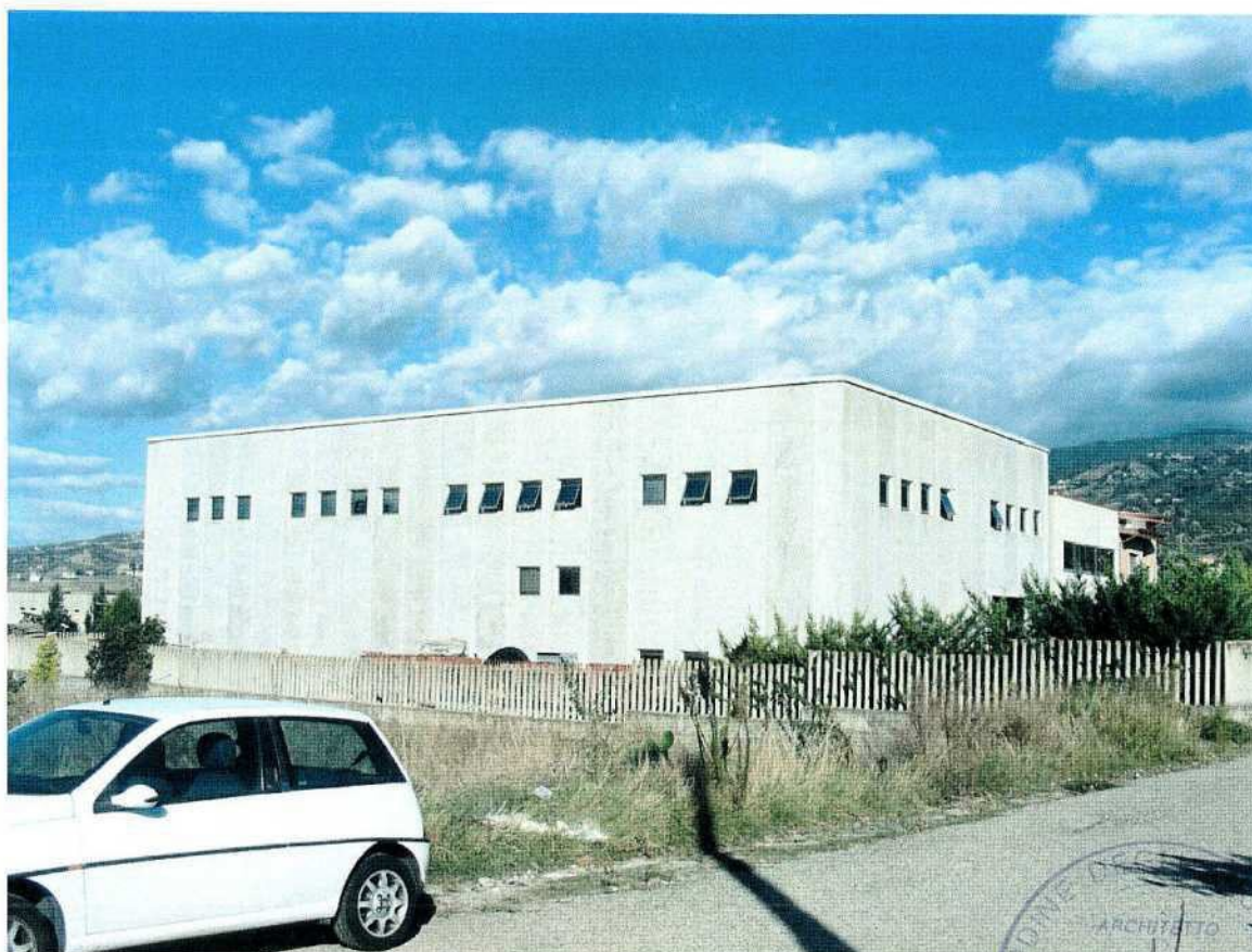
Foto 11 – Cespite n°2: veduta generale del secondo capannone industriale (prospetti ovest e sud)
