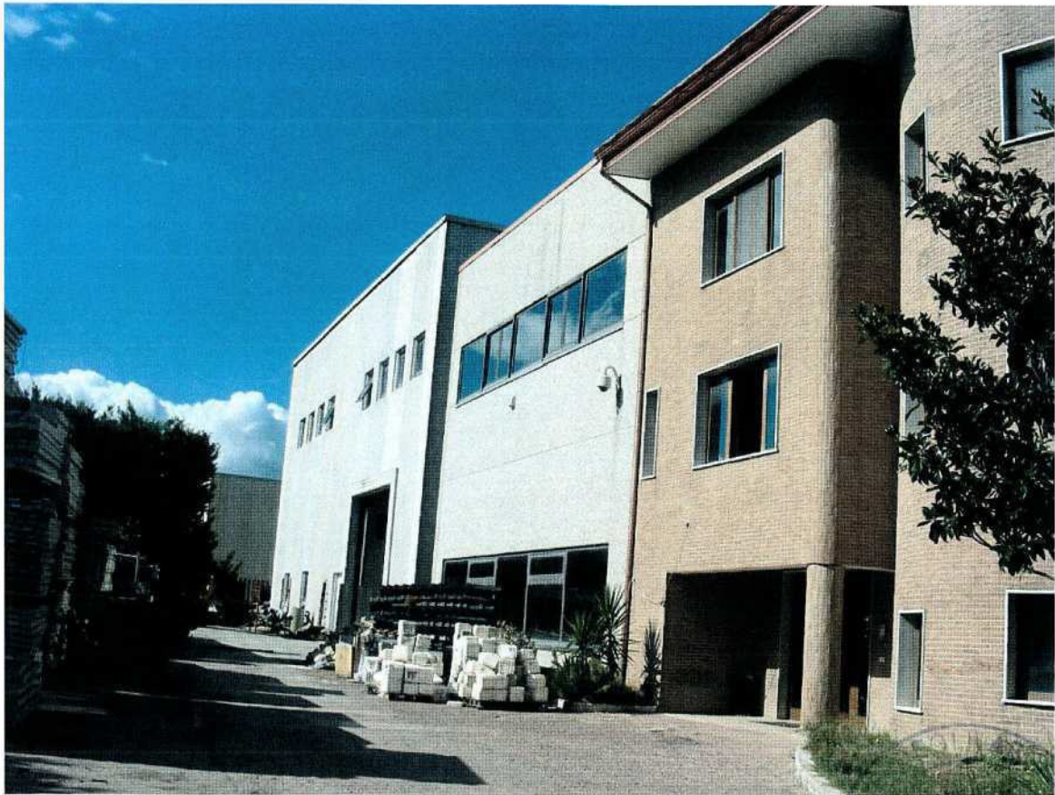
Foto 03 – Cespite n°1: veduta laterale del primo capannone industriale (prospetto sud visto di scorcio)
