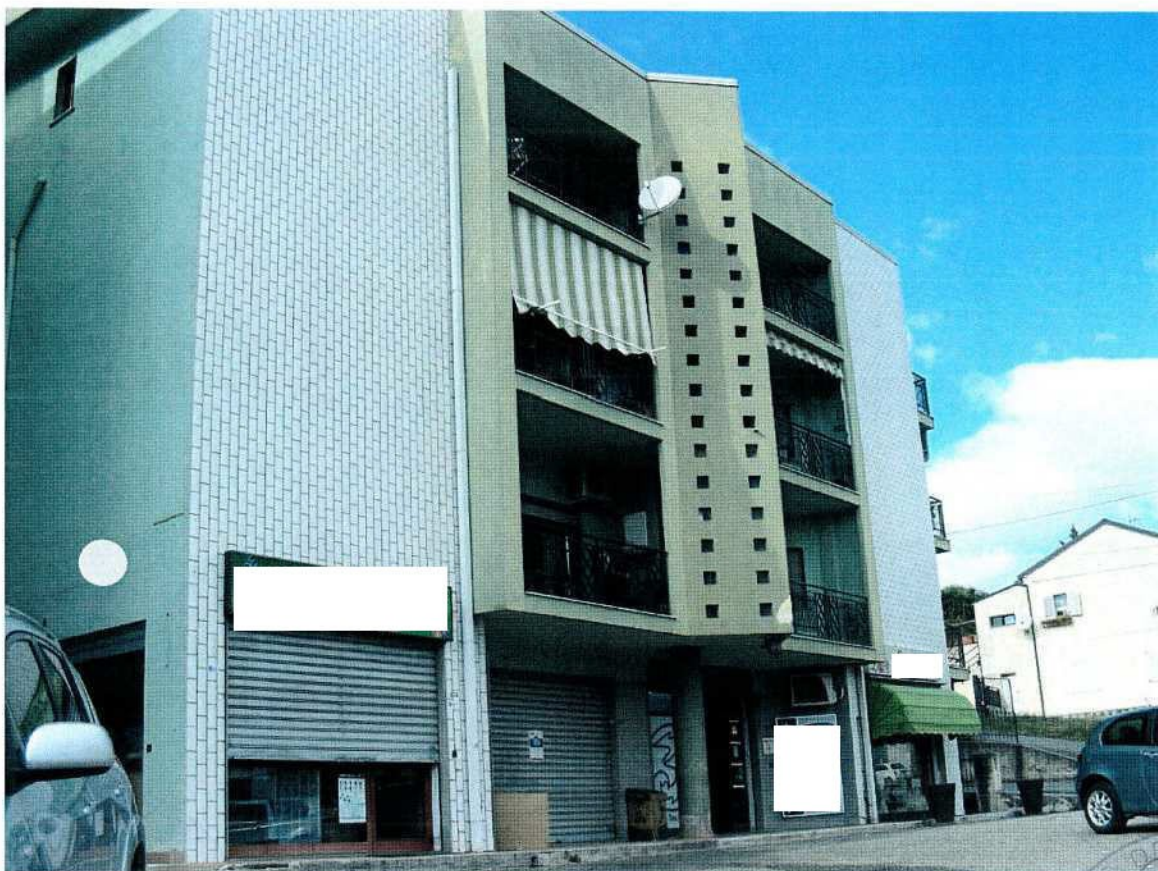
Foto 21 – Cespite n°4: veduta generale del fabbricato (prospetto laterale ovest visto di scorcio)
