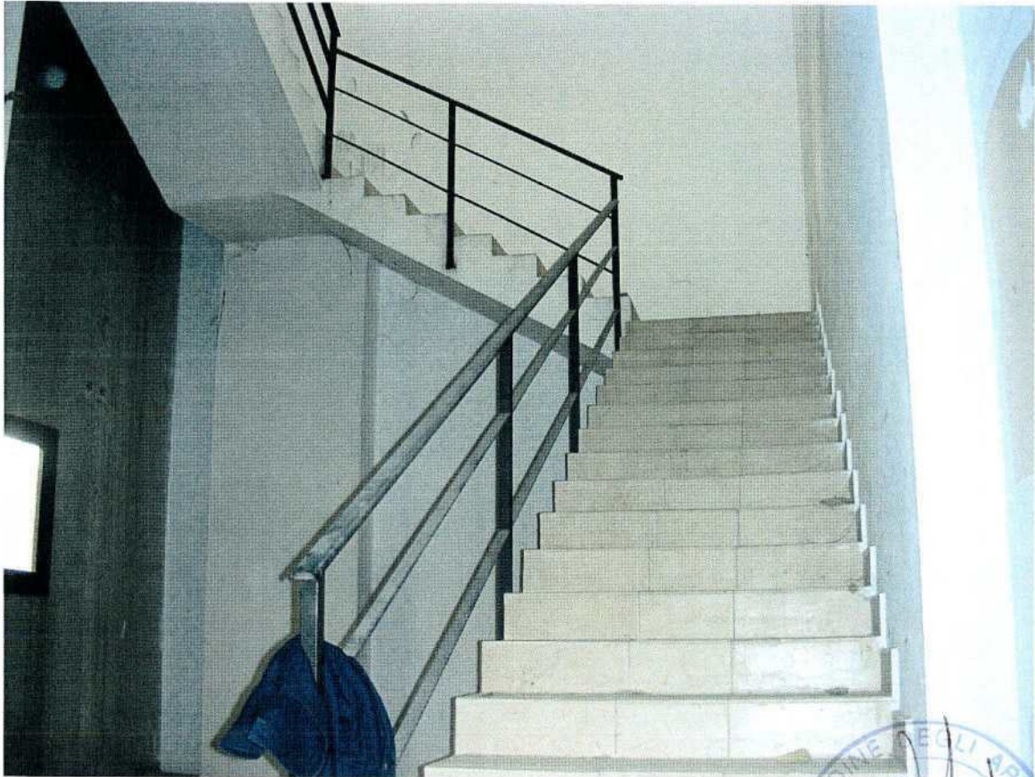
Foto 15 – Cespite n°2: veduta della scala di accesso al piano primo
