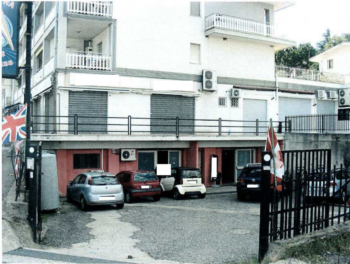
Foto 19 – Cespite n°3: veduta generale del fabbricato e della corte d'accesso (prospetto laterale nord)
