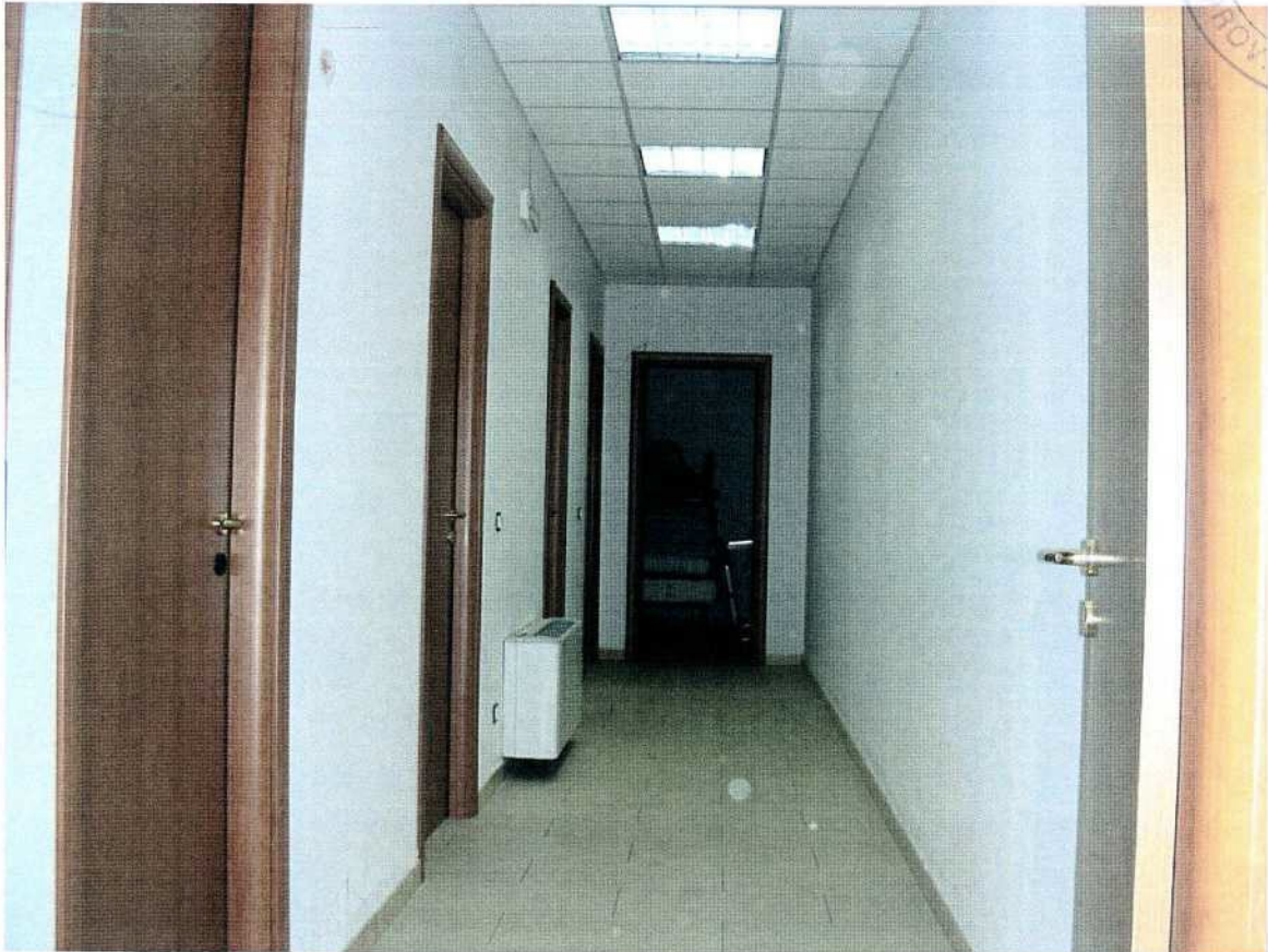
Foto 18 – Cespite n°2: veduta della zona uffici al piano primo
