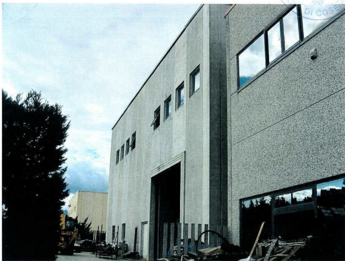
Foto 12 – Cespite n°2: veduta della zona d'ingresso del secondo capannone industriale (prospetto sud visto di scorcio)
