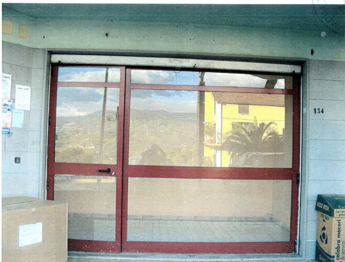
Foto 22 – Cespite n°4: veduta della porta/vetrina su via Trieste (prospetto laterale ovest)
