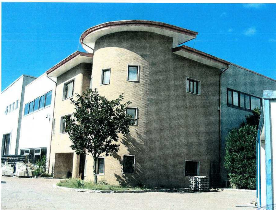
Foto 01 – Cespite n°1: veduta della zona d'ingresso del primo capannone industriale (prospetti ovest e sud visti di scorcio)
