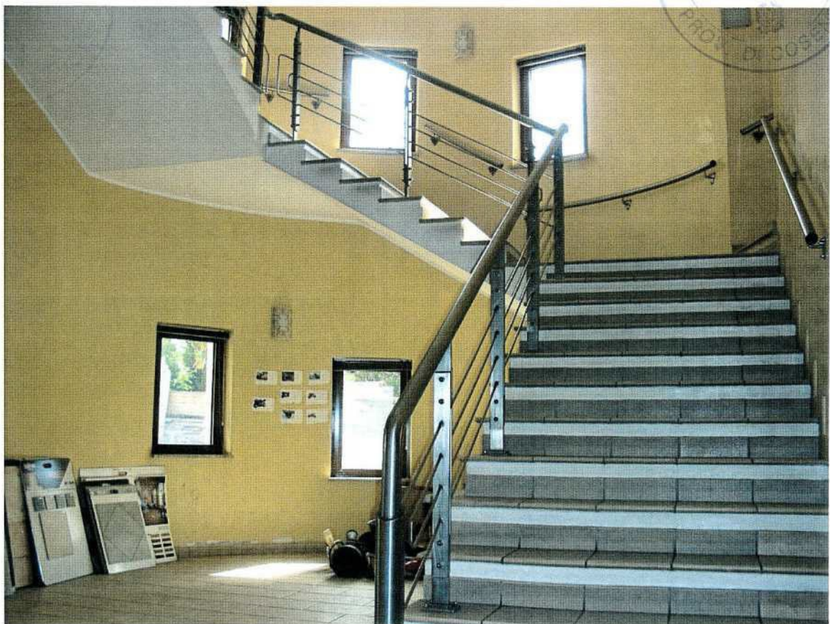
Foto 04 – Cespite n°1: veduta della scala nella zona d'ingresso
