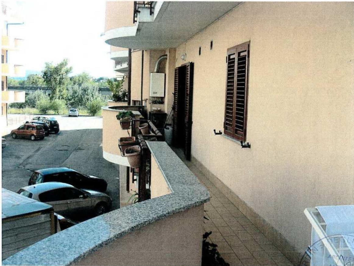
Foto 27 – Cespite n°5: veduta del balcone (facciata est)
