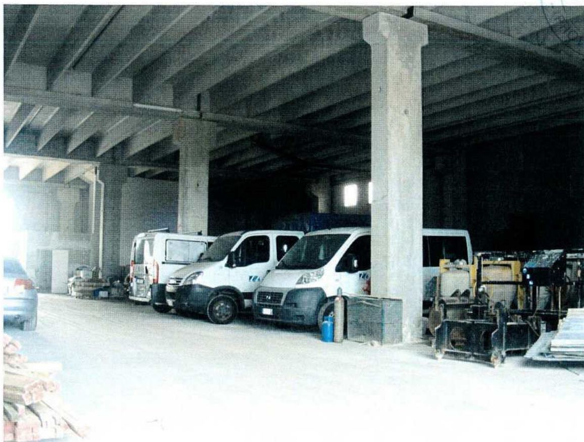
Foto 14 – Cespite n°2: veduta della zona depositi al piano terra
