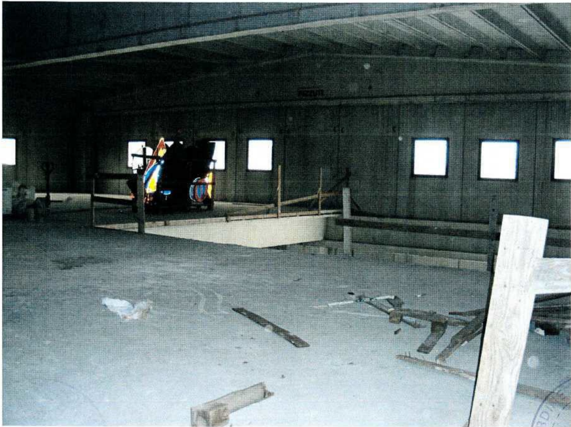
Foto 17 – Cespite n°2: veduta della zona soppalcata al piano primo
