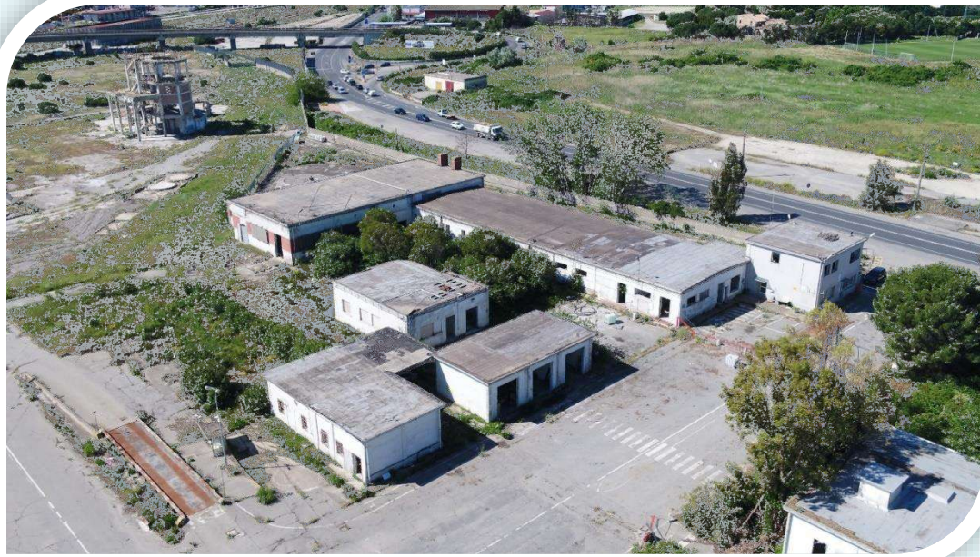
Vista aerea dettagliata edifici a Ovest
