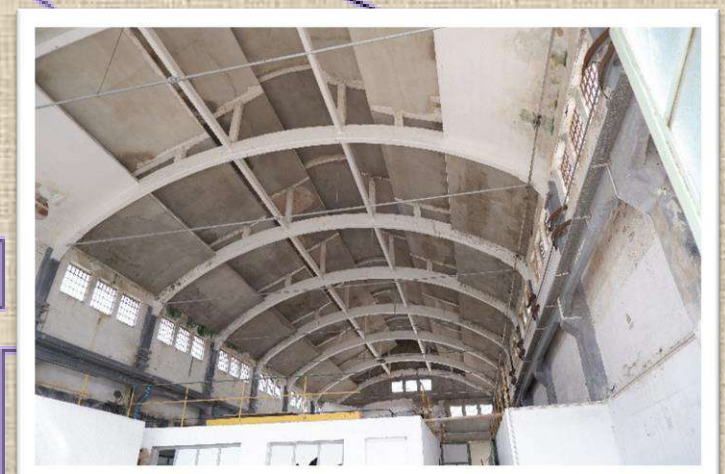
Sub.27 - Magazzino Motori e Pompe
