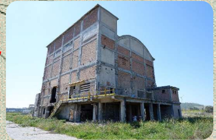
Sub.28 – ex Centrale Termica (prevista in demolizione)
