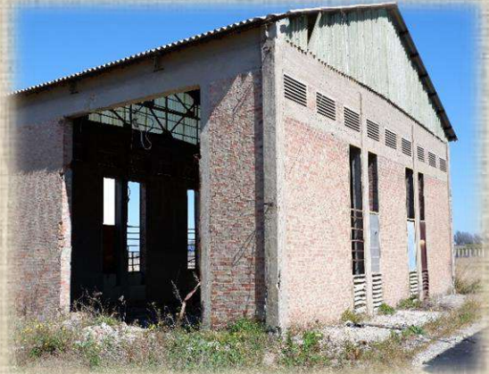
Sub.22 – Locale Diesel (previsto in demolizione)
