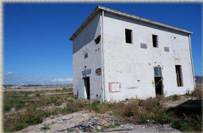
Sub.21 – Cabina elettrica (prevista in demolizione)
