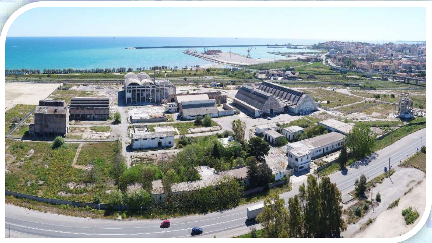
Vista panoramica aerea da Ovest
